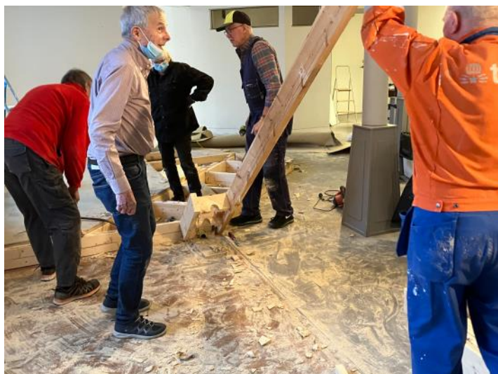
Plattformen rivs. Reglarna sparas till Asptorpsstugans restaurering.
